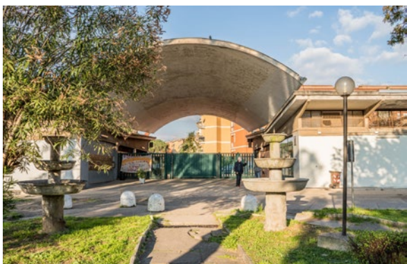
Arco d'ingresso all'Unità di Abitazione Orizzontale, Via Selinunte 49, architetto Libera (foto Claudio Bernardini 2021)
